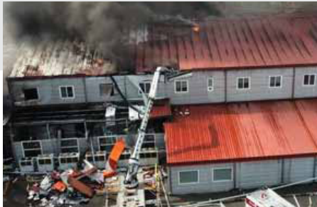
Cháy nhà xưởng
